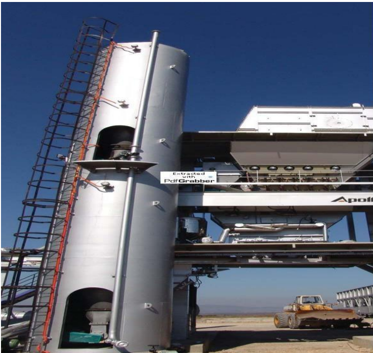
Fig. Mineral filler unit
