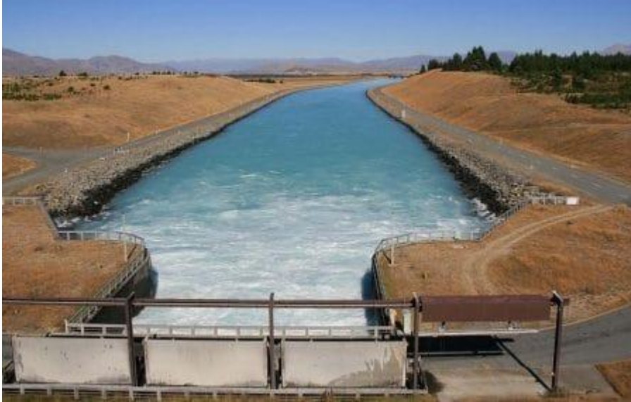
Fig: Power Canal
