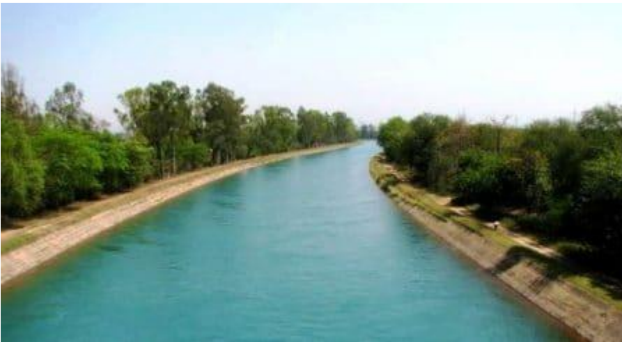
Fig: Feeder Canal
